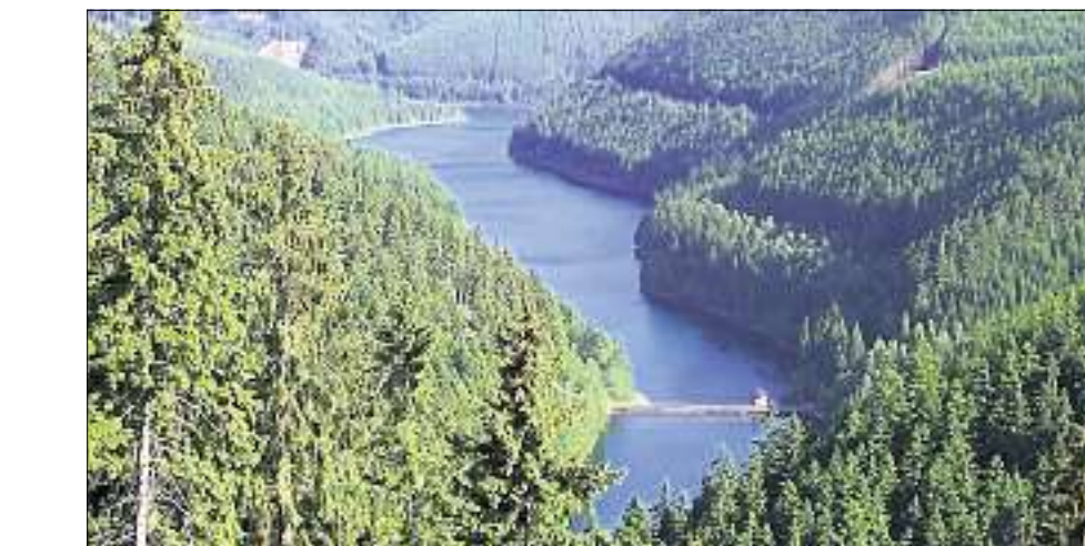
FERNWASSER: Aus der Ohratsperre werden auch Teile der Region versorgt.
